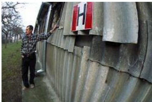
Rysunek 5 Ściana boczna budynku z płyt cementowo-azbestowych:
