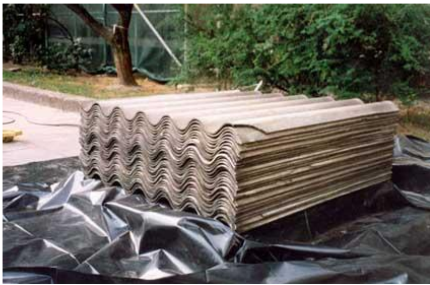
Rysunek 3 Przygotowanie wyrobów azbestowych do transportu:
