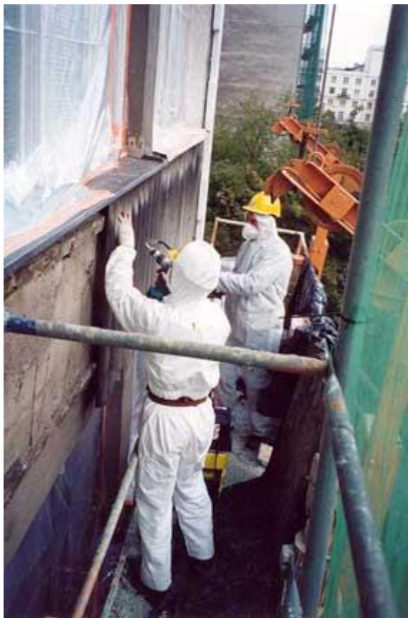
Rysunek 3 Przygotowanie wyrobów azbestowych do transportu:
