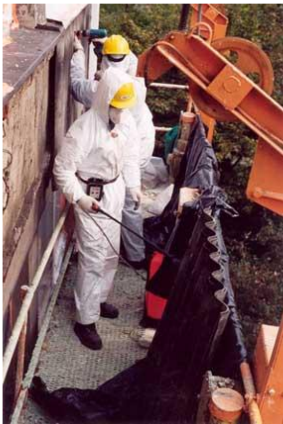
Rysunek 2 Usuwanie wyrobów azbestowych:
