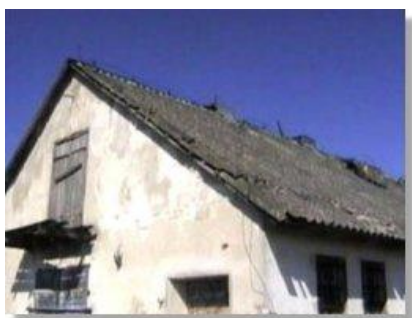
Rysunek 6 Znaczne uszkodzenia powierzchni azbestowych płyt falistych na dachu budynku:
